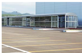
设置在停车场里的拱廊及融雪装置
