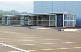
设置在停车场里的拱廊及融雪装置
