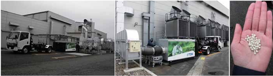
在排热地点通过蓄热材料蓄热
